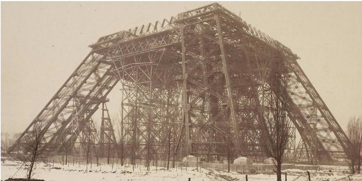
Les presses hydrauliques dans chaque pied de la Tour permettent de rectifier l'inclinaison de l'ouvrage jusqu'à l'assemblage de la première plate-forme.
